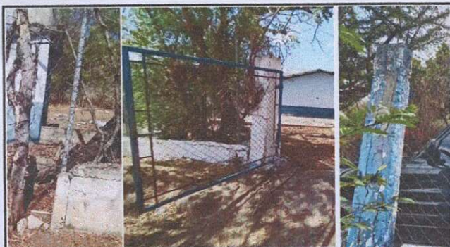
Foto 3: a. Sustitución de malla rota y oxidada mas reparación de block en mal estado del muro perimetral, b. Sustitución de portones de malla con tubo galvanizado y c. Reparación, resanado y refuerzo de columnas de concreto de soporte de portones
