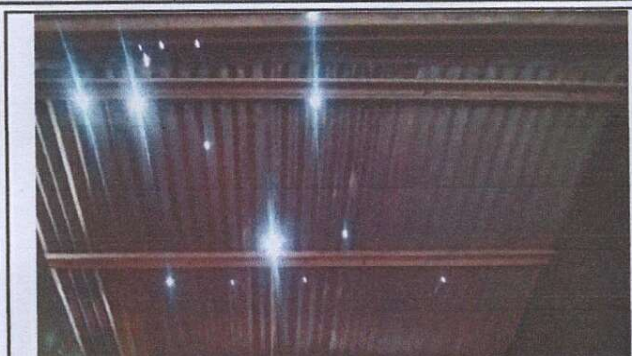
Foto 1: El techado se encuentra en mal estado así como la estructura de la cubierta, ocasionando problemas en la época de lluvia
